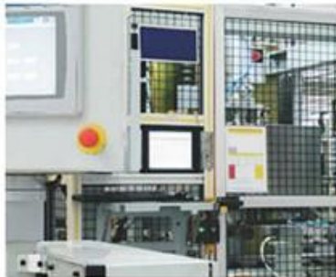
sliding door area
